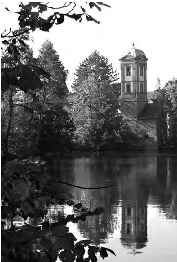
Unterer St. Jakobs Wasserturm
