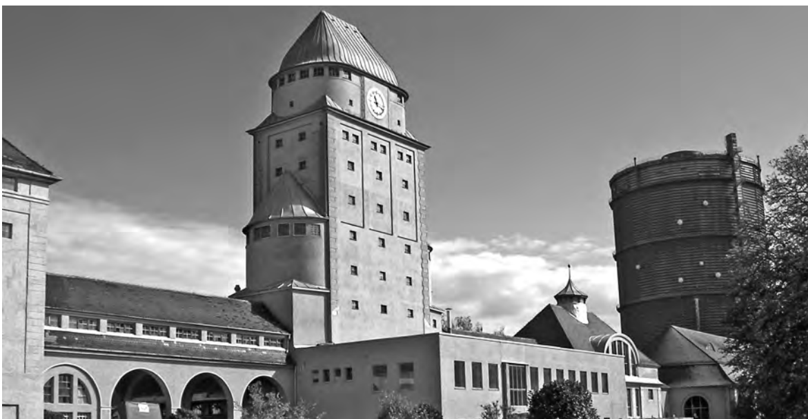
Gaswerk – Behälterturm und Scheibengasbehälter
